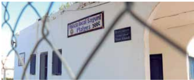
Edificio Voro Alandí de Almardà (Sagunt). / EPDA
