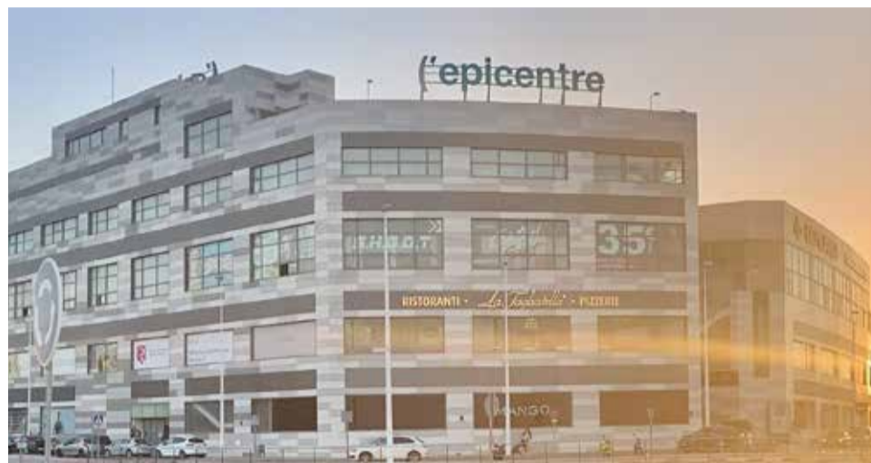
Centro Comercial Lepicentre. / EPDA
