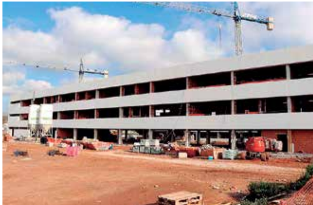
Obras del IES número 5 de Port de Sagunt. / EPDA
