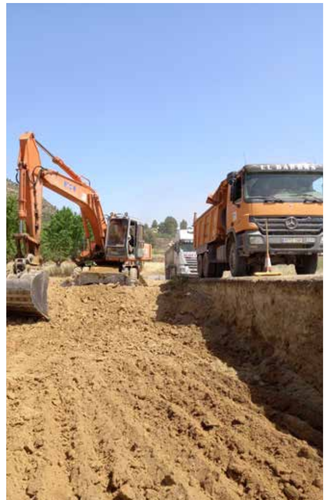
Trabajos de mejora de la carretera / EPDA
