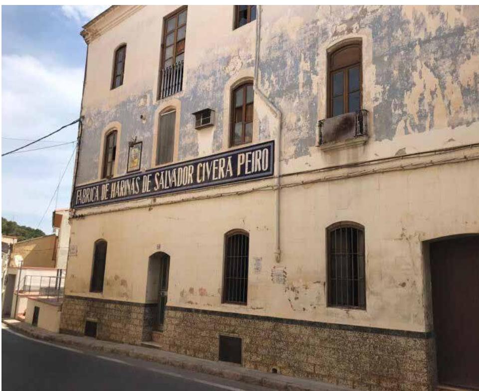
Edificio del molino en Pedralba. / EPDA
