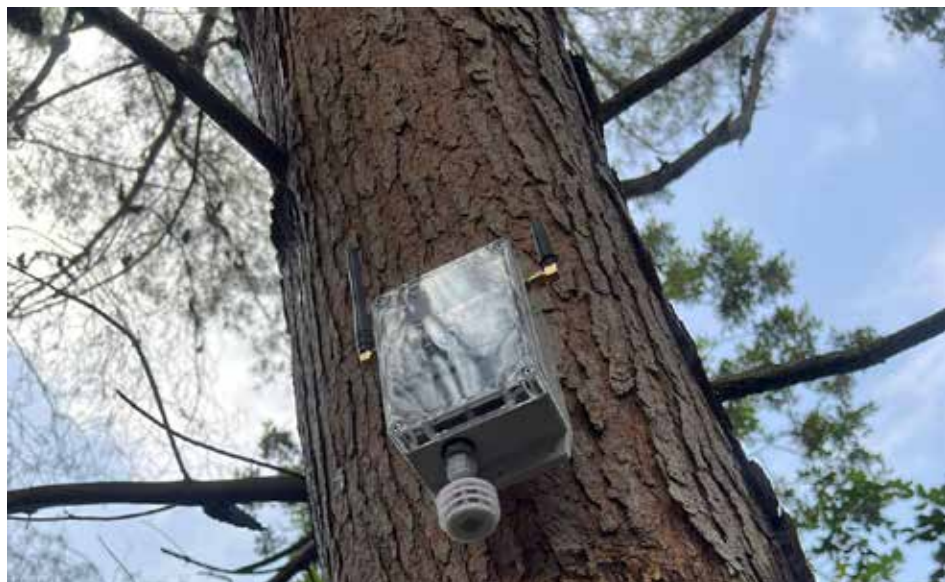
Uno de los equipos de monitorización. / EPDA
