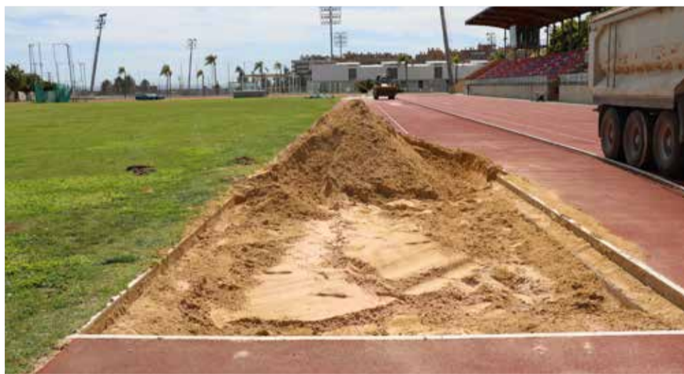
Treballs a Parc Central. / EPDA
