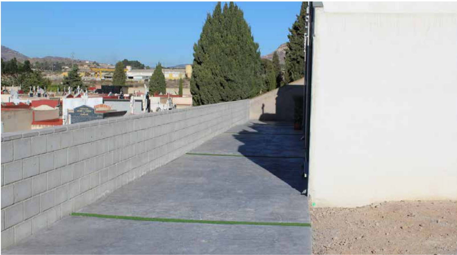
Obras de mejora en el Cementerio Municipal de Novelda. / EPDA
