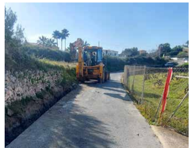
Renovación de tuberías. / EPDA
