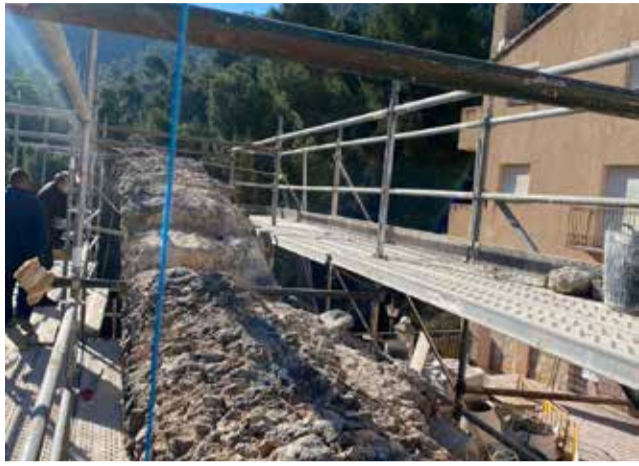
Trabajos de recuperación. / EPDA
