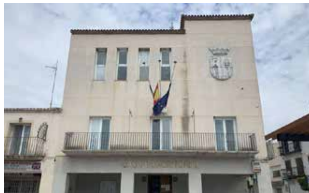
Fachada del Ayuntamiento. / EPDA
