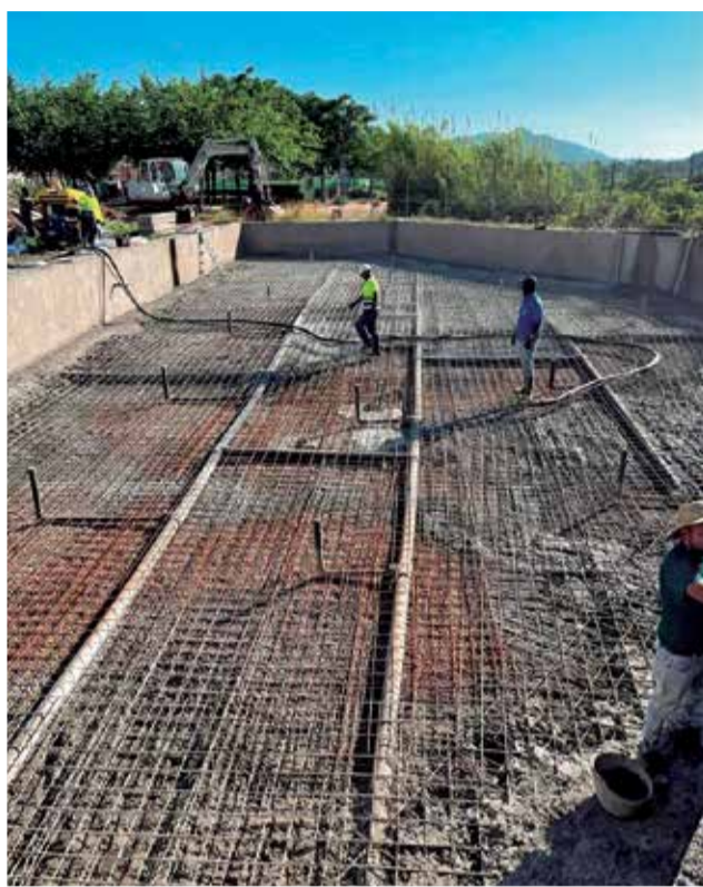
Obras de la piscina en Alfara de la Baronia. / EPDA
