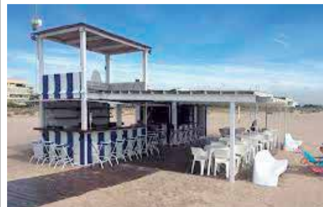
Chiringuito afectado en la playa de Almardà. / EPDA
