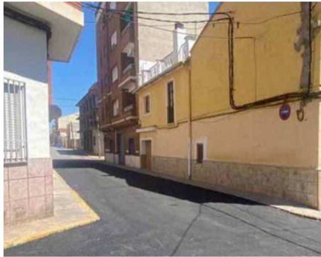
Asfaltado de Benaguasil. / EPDA
