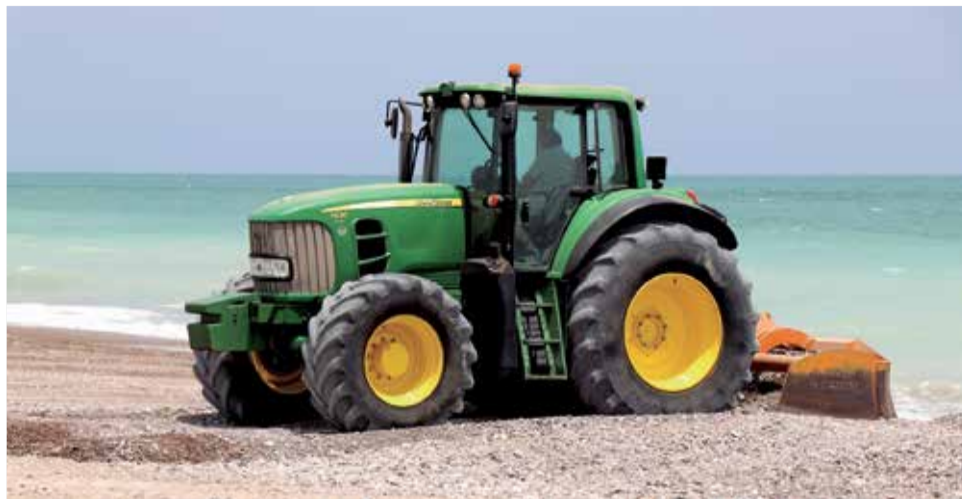
Un tractor llevando a cabo actuaciones de nivelación de la playa de Corinto. / EPDA
