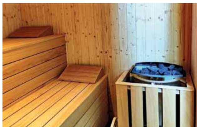
Sauna de la Piscina Municipal / EPDA
