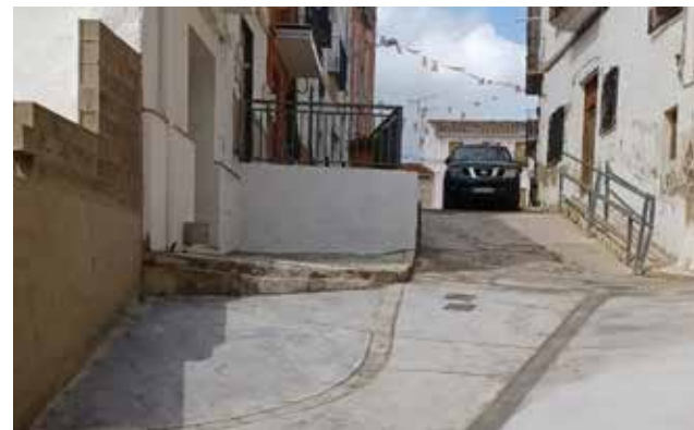
La calle de San Antonio en Losa. / EPDA
