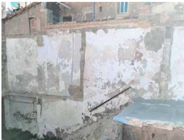
Interior de la Casa Abadía en su estado actual. / EPDA
