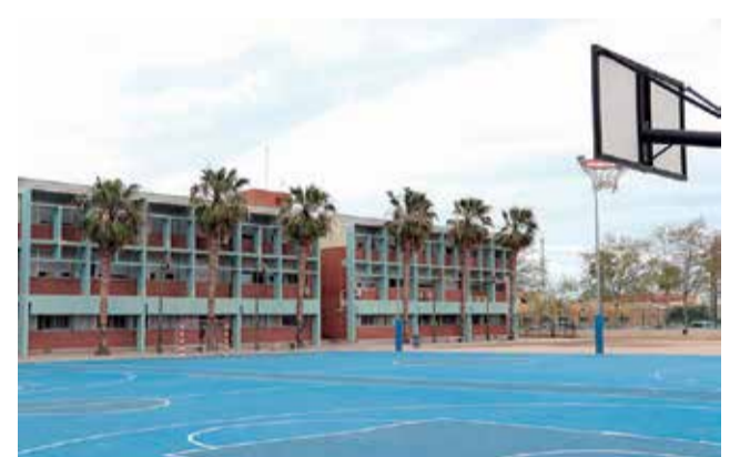
Instalaciones del IES Camp de Morvedre. / EPDA
