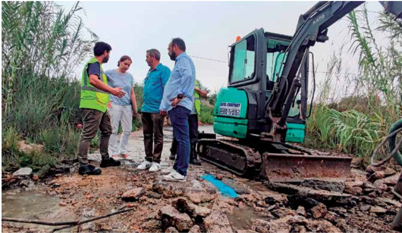
Visita a las obras de asfaltado. / EPDA
