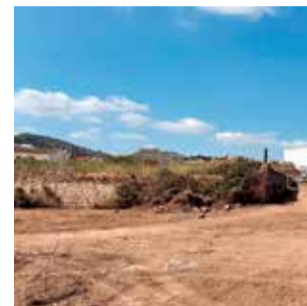
Obra de canalización. / EPDA
