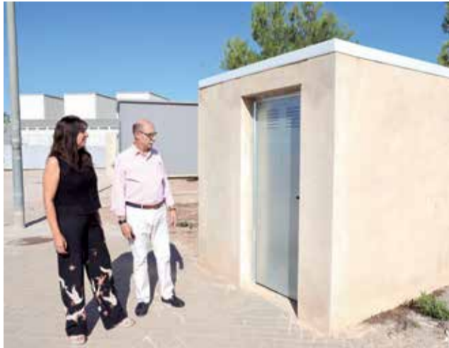
Visita a las obras. / EPDA
