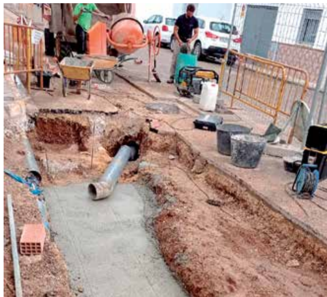
Obras en la red de aguas pluviales de Casinos. / EPDA
