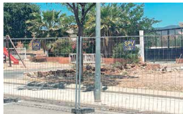
Obras para la nueva escoleta. / EPDA
