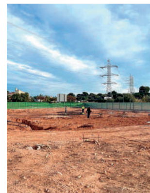
Obras Centro Cívico. / EPDA
