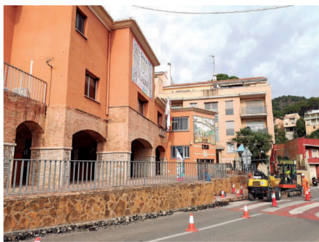
Obras en la carretera CV-310 a su paso por Serra. / EPDA
