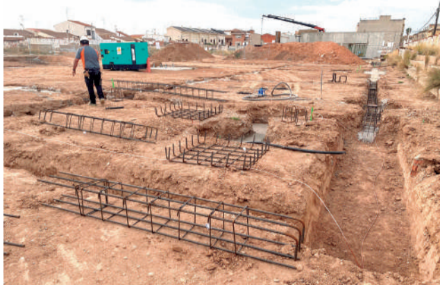
Ejecución de las obras del centro de día. / EPDA
