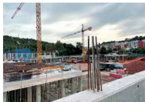
Estado actual de las obras. / EPDA
