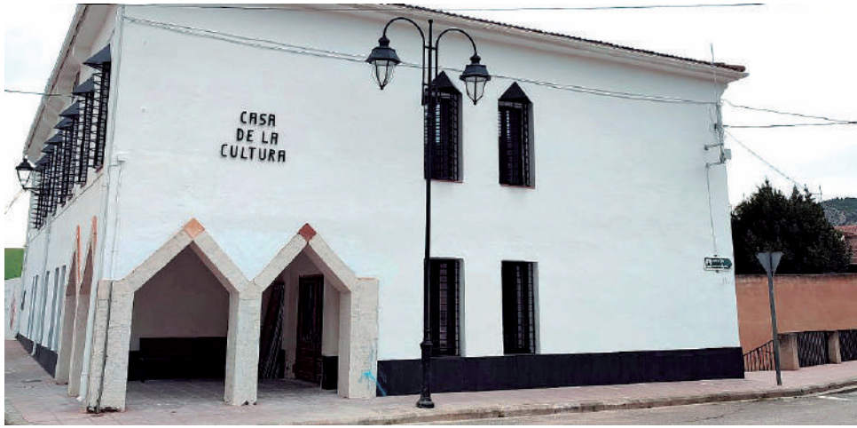
Edificio 'Casa de la Cultura' de Higuieruelas. / EPDA
