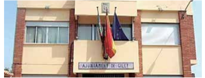
Fachada del ayuntamiento de Gilet. / EPDA
