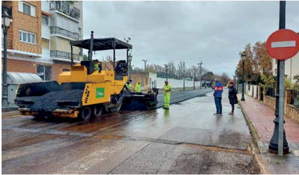
Asfaltado de la calle Alejandro García. / EPDA
