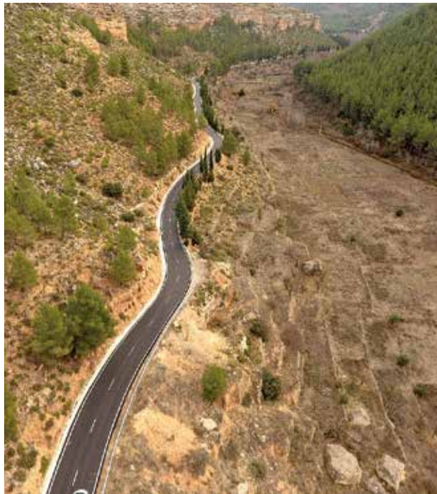
Una de las carreteras rehabilitadas. / EPDA
