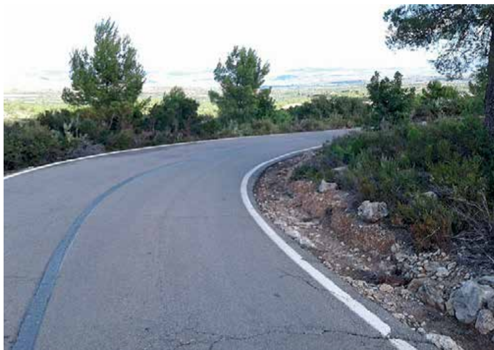
Una de las carreteras a rehabilitar. / EPDA
