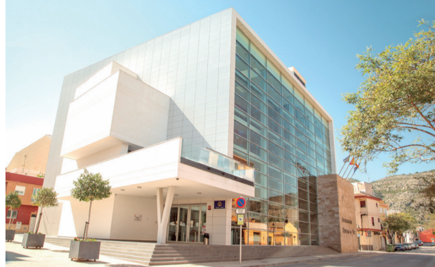
Fachada del Ayuntamiento de Oropesa. / EPDA
