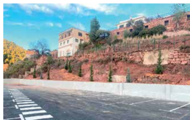
Nou pàrquing 'El Llavador' d'Olocau. / EPDA
