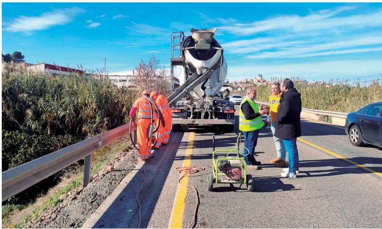
Obres a la CV-370 de Vilamarxant. / EPDA
