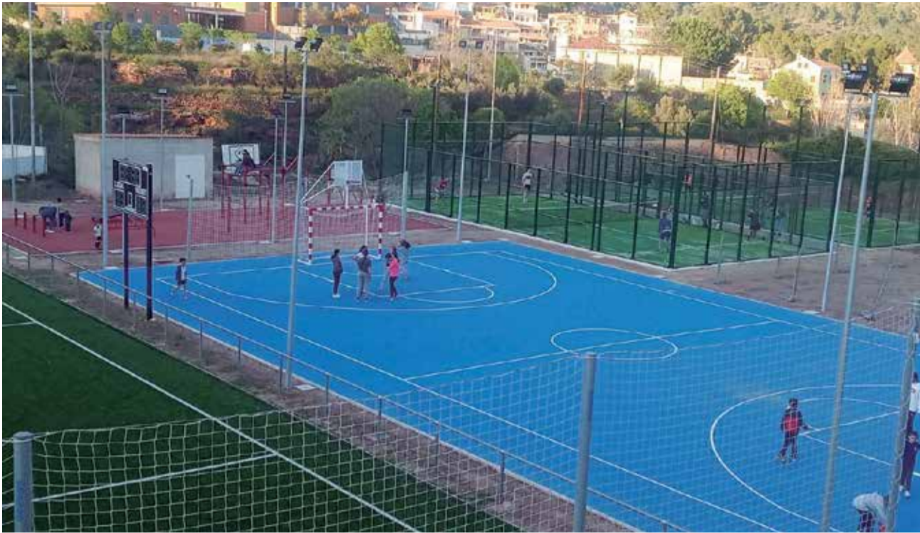
Polideportivo de Serra. / EPDA
