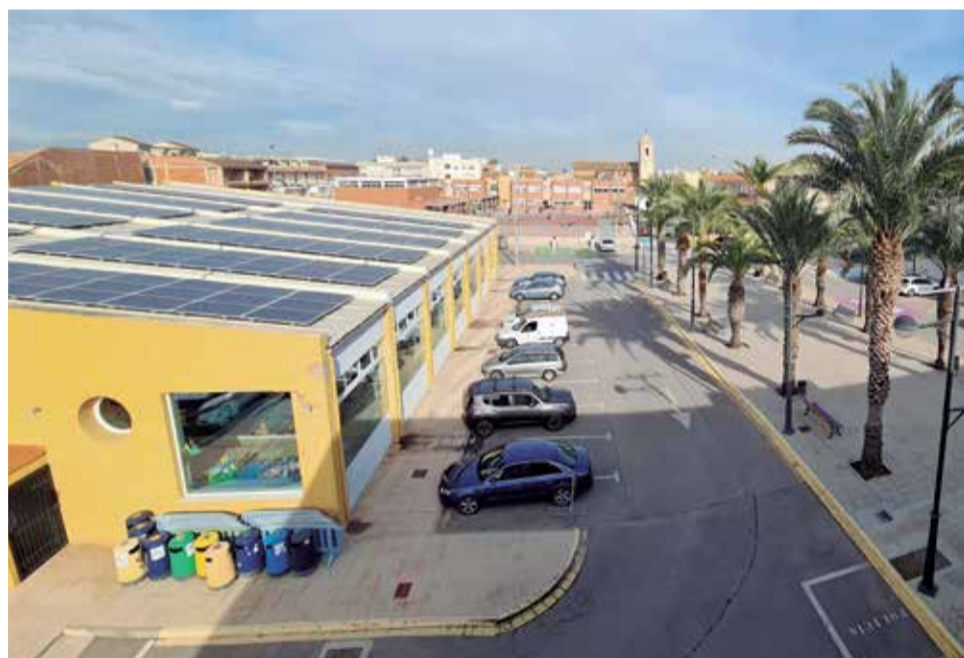
Placas solares instaladas en el tejado de la piscina municipal de Canet. / EPDA
