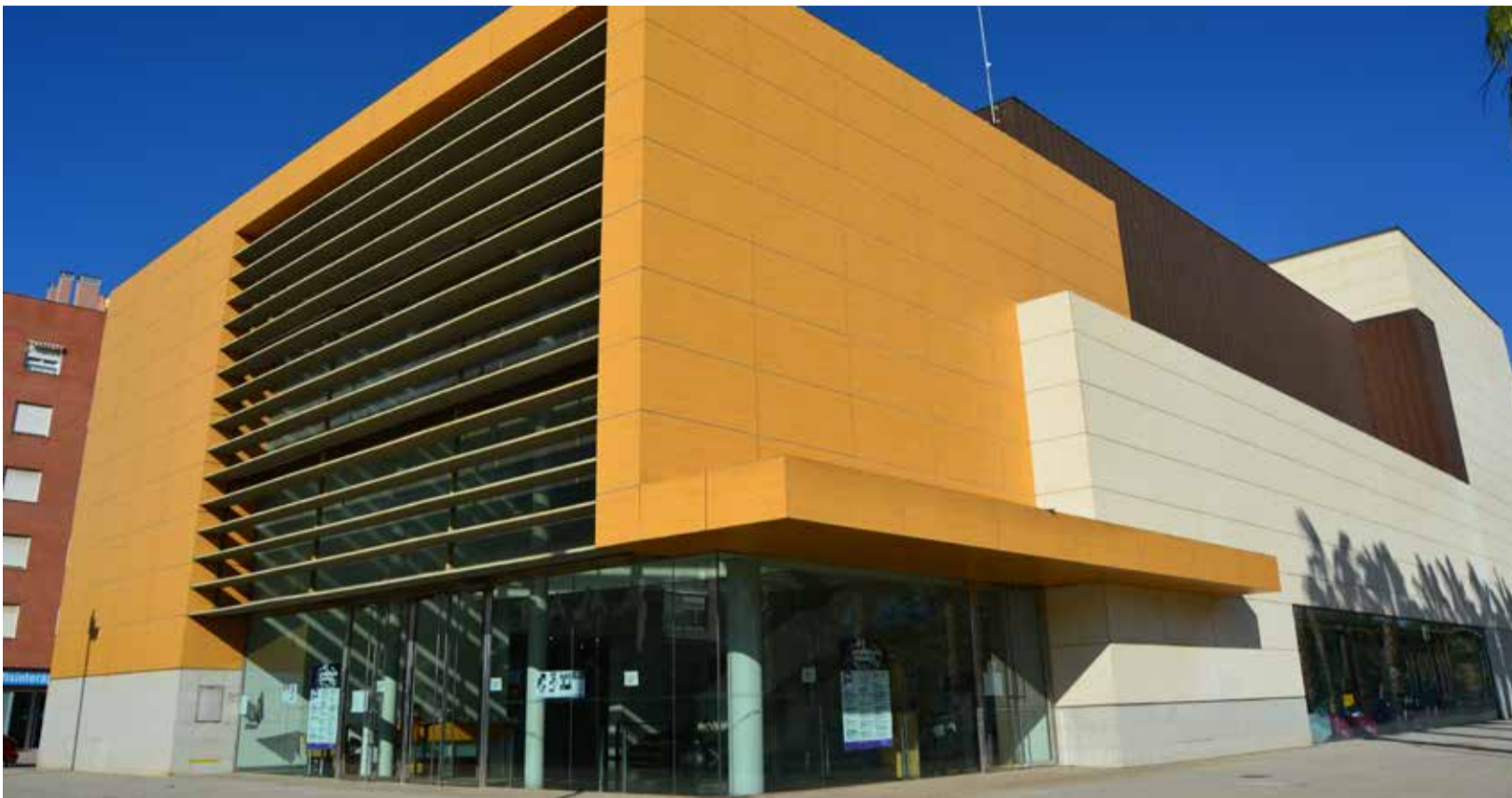
Fachada del TAMA de Aldaia. / EPDA
