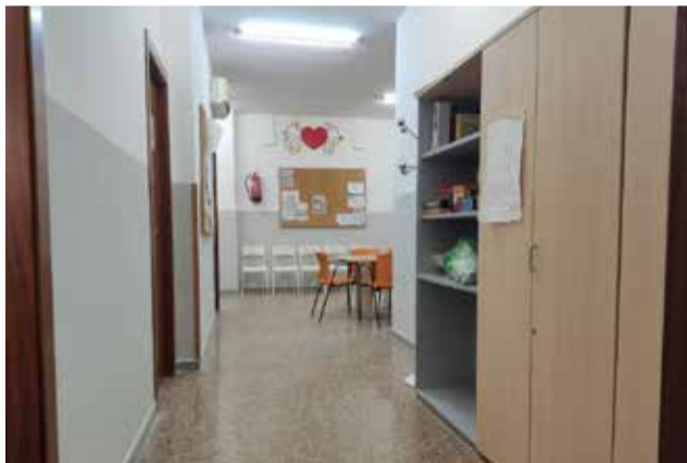
Espacio tras los trabajos. / EPDA
