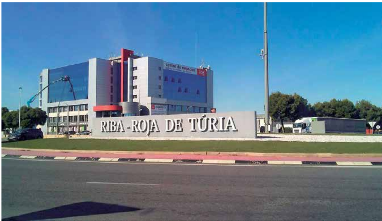
Rotonda de acceso al polígono industrial de Riba-roja de Túria. / EPDA
