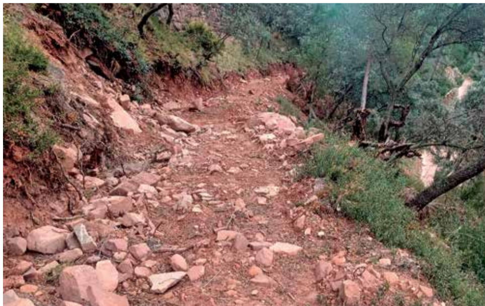
El primer paso ha sido remover las obras. / EPDA
