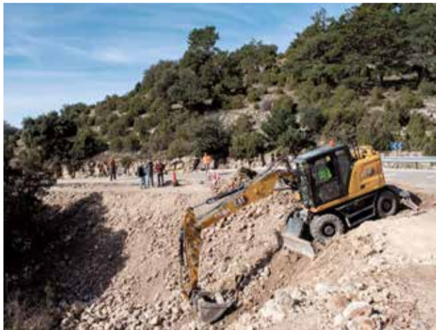
Obres de millora en la CV-111. / EPDA
