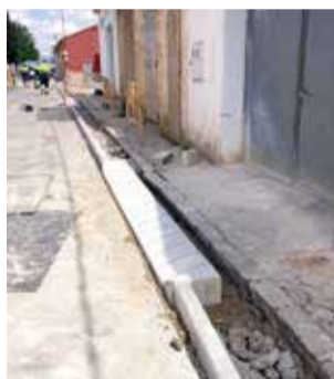
Trabajos realizados. / EPDA
