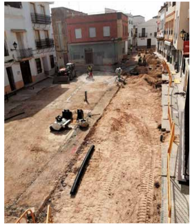
Obras de la plataforma única en Canet. / EPDA
