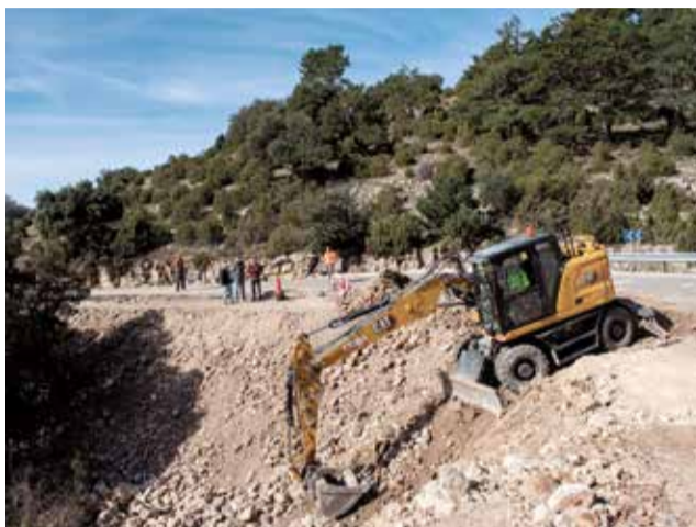
Obres de millora en la CV-111. / EPDA
