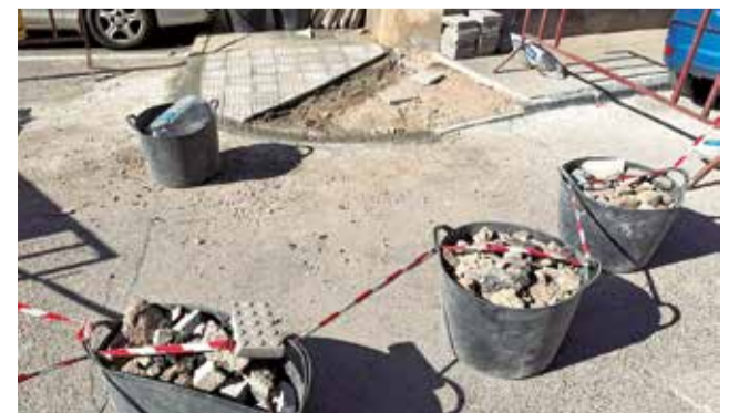
Obres a les voreres. / EPDA
