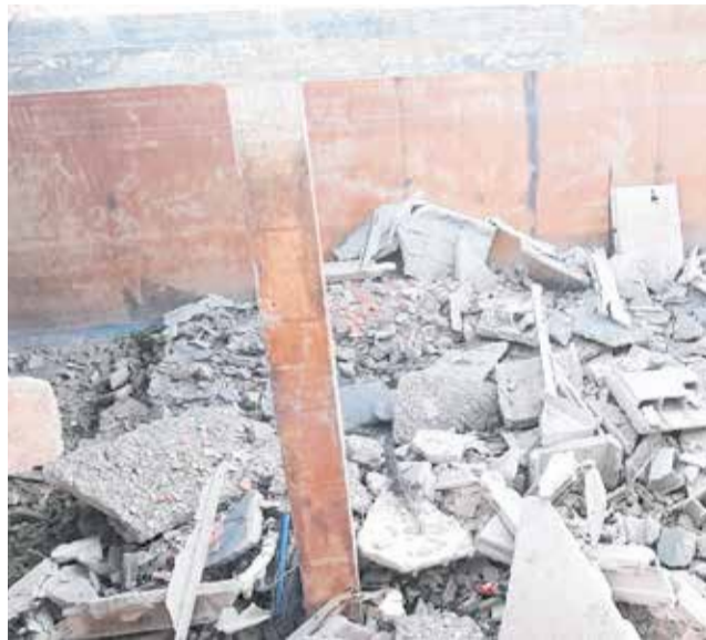
Estado actual del depósito de agua. / EPDA
