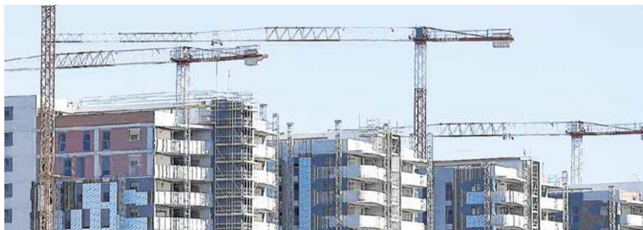
Construcción de edificios de viviendas, en una zona de expansión de Valencia. / EPDA
