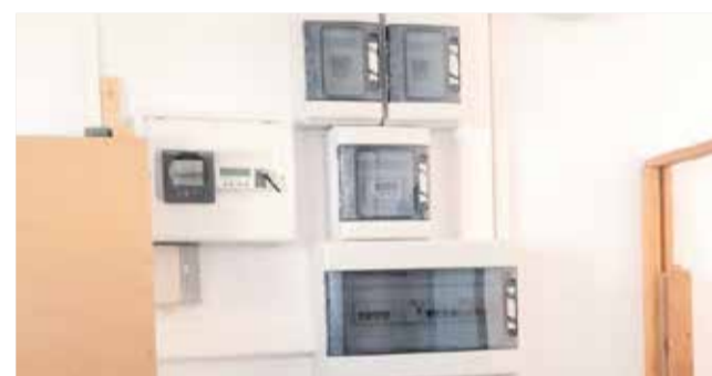
Nova instal·lació al poliesportiu. / EPDA
