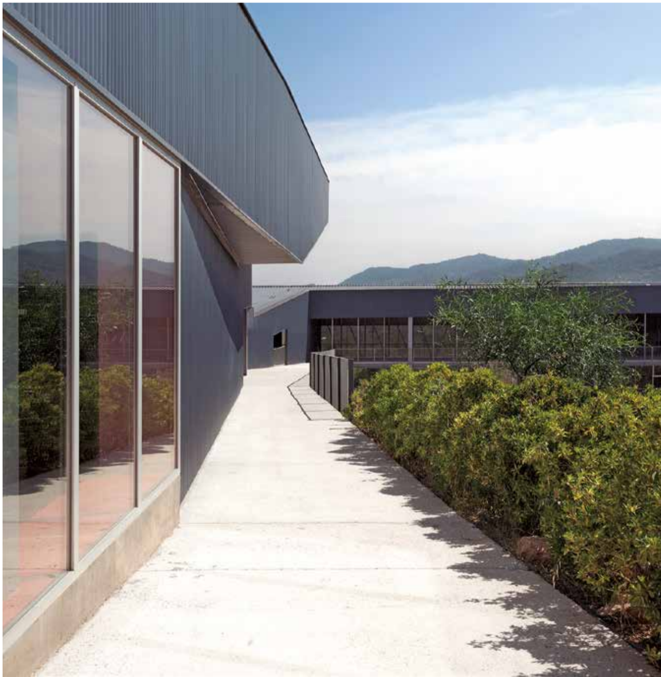
Instalaciones de la planta de residuos de Algimia d'Alfara, en el Camp de Morvedre. / EPDA
