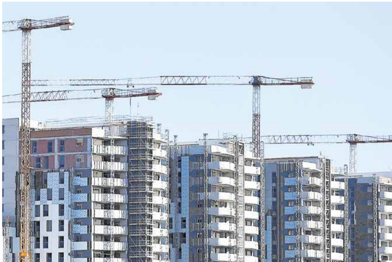
Construcción de edificios de viviendas, en una zona de expansión de Valencia. / EPDA
