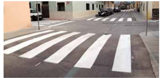
Trabajos de pintura vial. / EPDA
