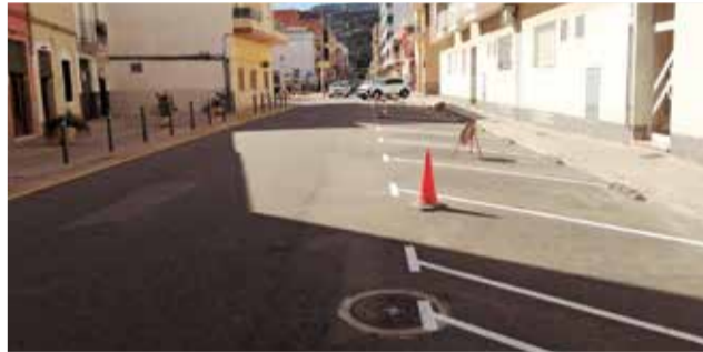
Trabajos de pintura vial. / EPDA
