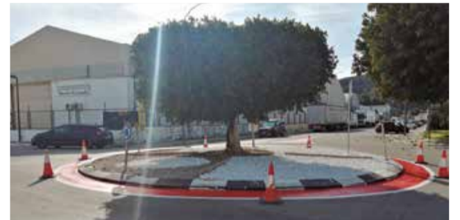
Trabajos de pintura vial. / EPDA
