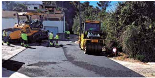
Trabajos de asfaltado en el barrio Pipa. / EPDA
