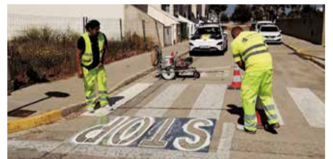
Operarios realizan trabajos de pintura. / EPDA
