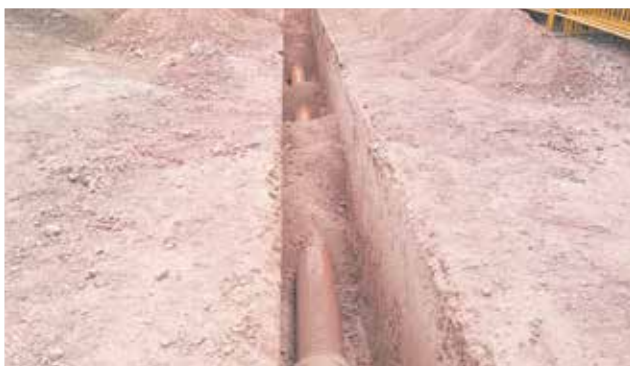
Obres a la urbanització 'El Peucal' de Nàquera. / EPDA
