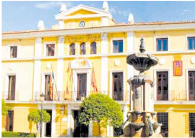
Fachada del Ayuntamiento de Segorbe. / EPDA
