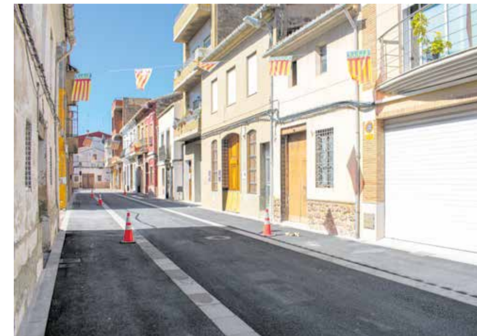
Las obras de urbanización que ya han concluido. / EPDA
