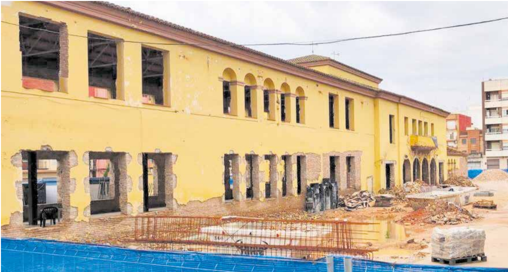
El edifici que se està construint per acoger el espai municipal. / EPDAW
