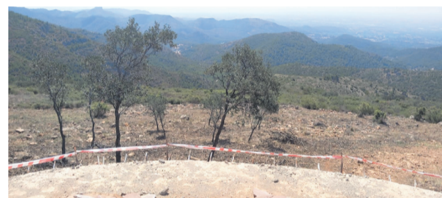
Obres al mirador de Rebalsadors de Serra. / EPDA
