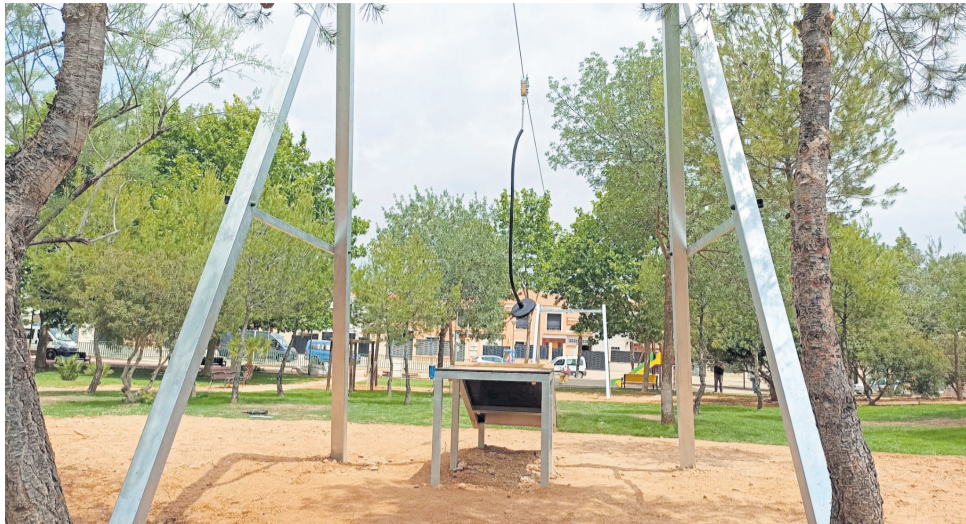
Nueva tirolina instalada en el parque Topairet de Benaguasil. / EPDA
