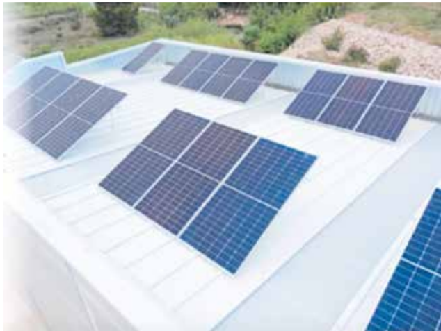
Plaques instal·lades en el magatzem municipal. / EPDA
