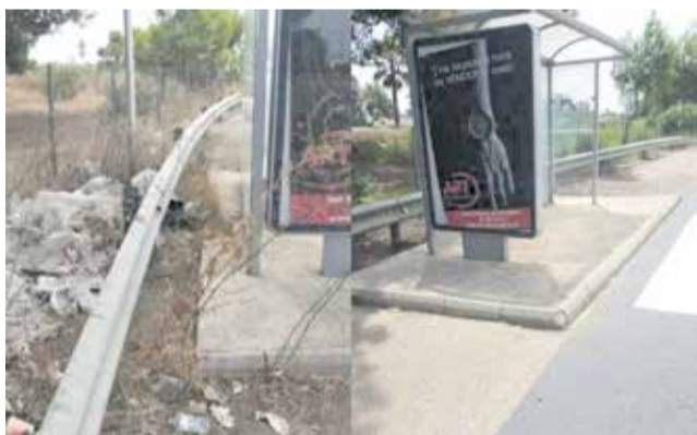
Antes y después del estado de la marquesina. / EPDA
