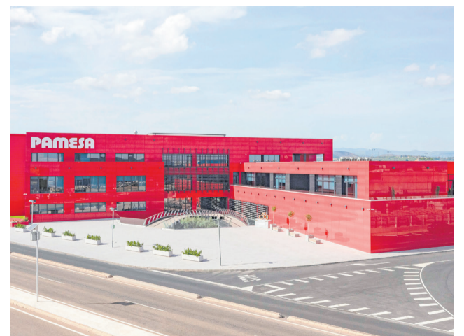
Fachada de las instalaciones de Pamesa. / EPDA
