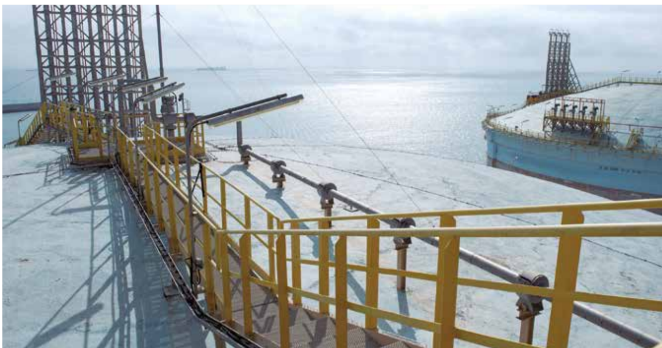
Instalaciones de Saggas en Sagunt. / EPDA
