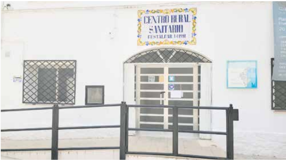
Fachada del consultorio médico del municipio de Gestalgar. / EPDA
