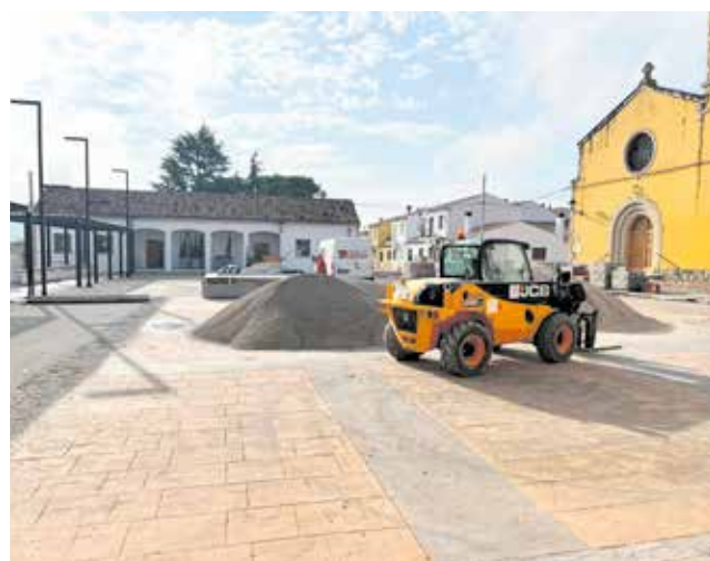
Trabajos de rehabilitación de la plaza Pío XII. / EPDA
