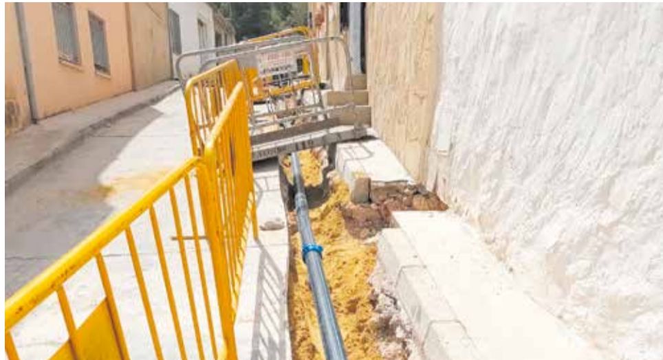
Obras de acondicionamiento en el barrio Barranquet-Jerusalem. / EPDA
