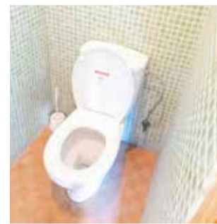
Trabajos realizados. / EPDA
