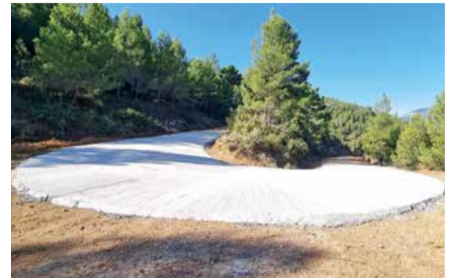
Una de las carreteras asfaltadas. / EPDA
