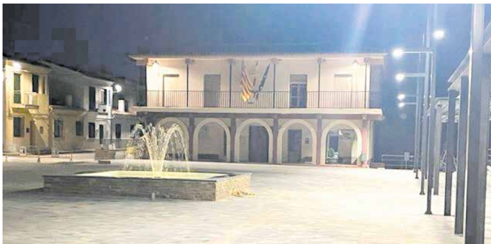
Estado actual de la plaza de Pío XII de Benagéber. / EPDA
