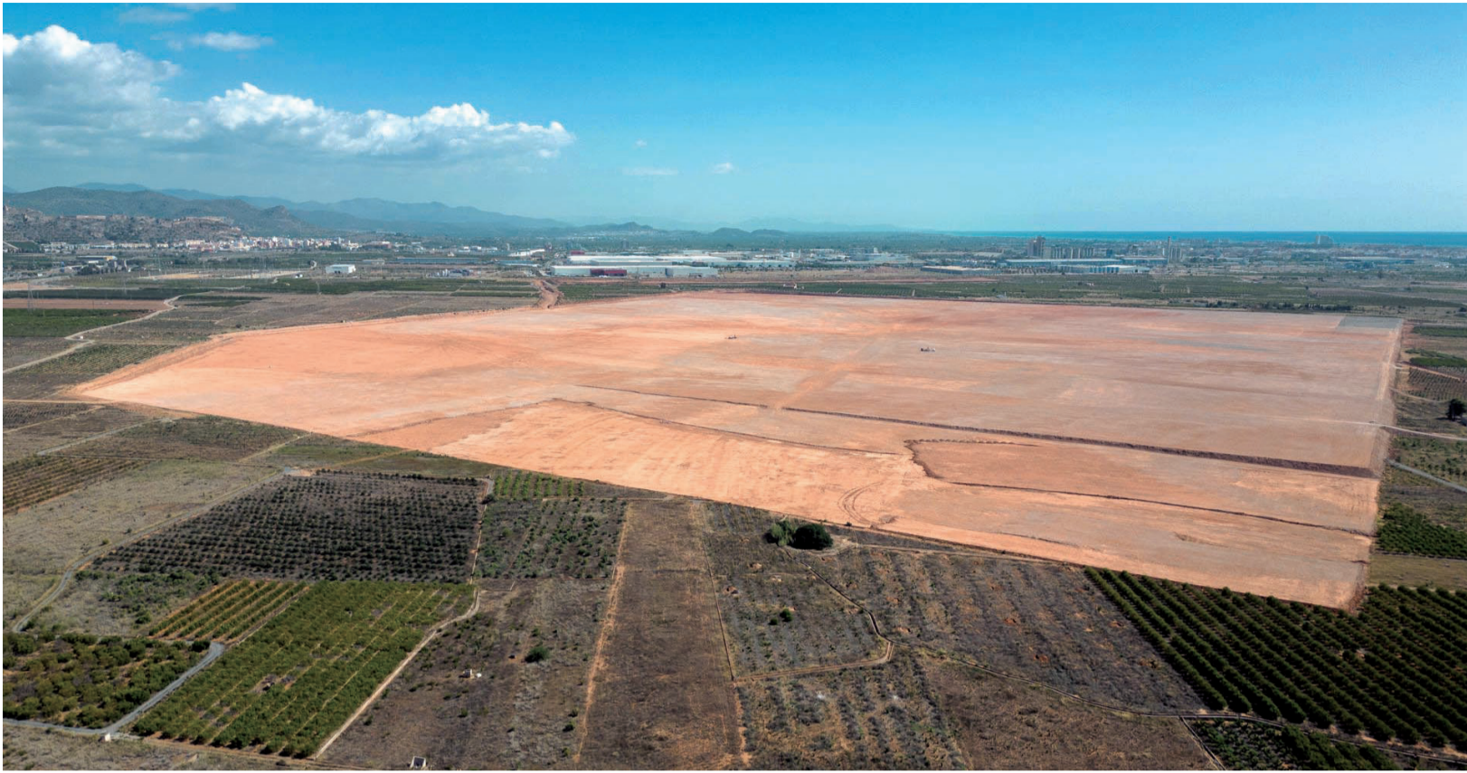
Vista aérea, tomada desde un dron, de las obras donde se ubicará la gigafactoría. / EFE
